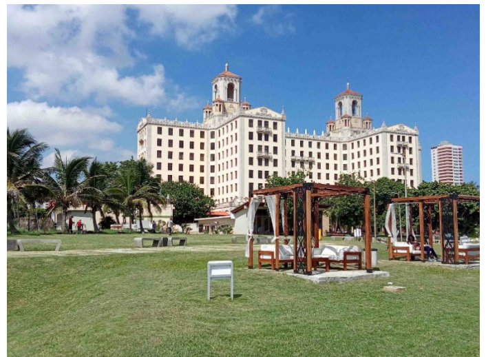
Figura 2. Imagen del Hotel Nacional de Cuba sobre el carso cubierto por una delgada capa de suelo , de la segunda terraza costera del litoral norte de La Habana. Fuente: Instituto de Geofísica y Astronomía, 2024.
