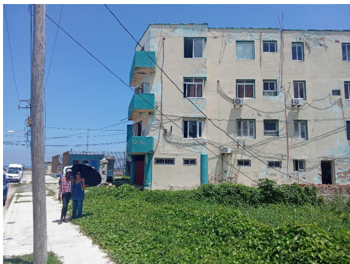
Figura 13. Edificio No. 53 en Je/ 1 ray Calzada, Vedado, Plaza de la Revolución, allende a un terreno baldío con evidencias de pequeñas cuevas, en las mediciones del sondeo eléctrico vertical. Fuente: Instituto de Geofísica y Astronomía, 2024.
