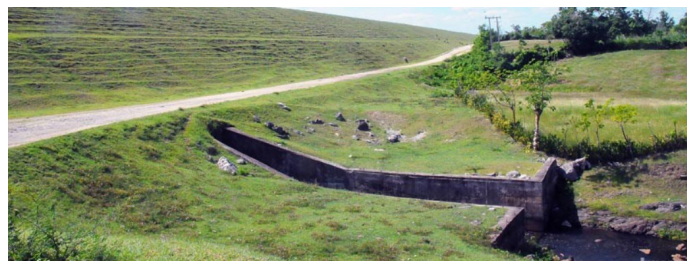
Figura 2. Descarga ecológica de la presa Chambas.
