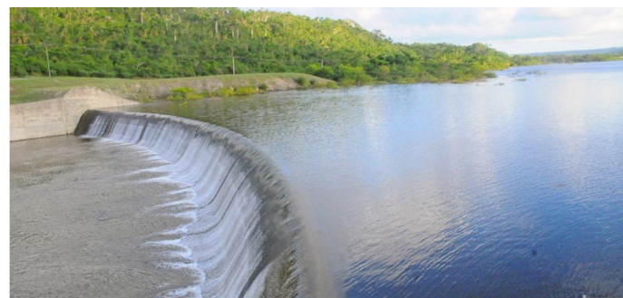
Figura 3. Vertimiento presa Chambas.
