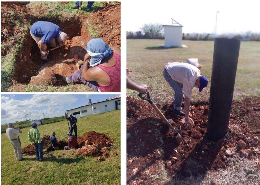
Figura 8: Proceso constructivo del pilar.
