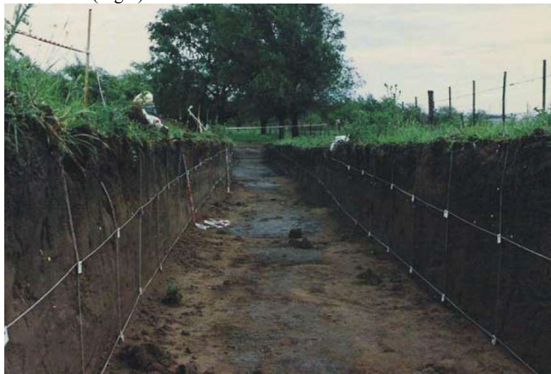
Fig. 5. Ejecución de trincheras. Fuente: Sagripanti, 2006
