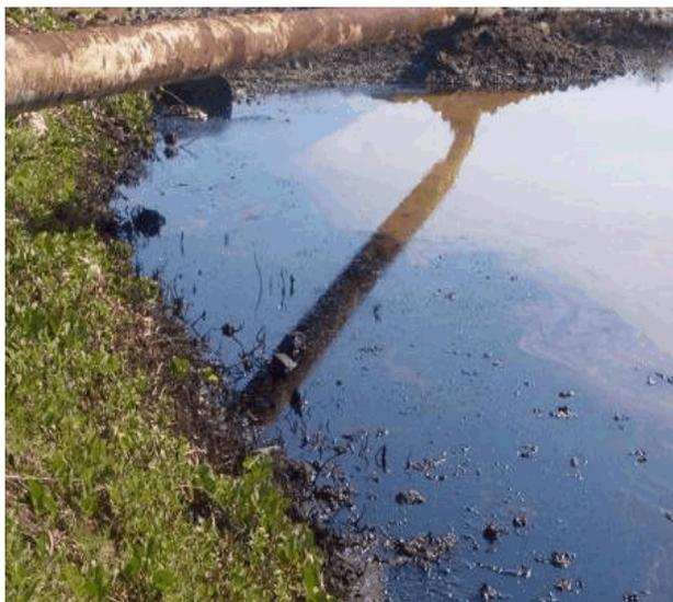
**Foto 3. Derrame de los lodos por rompimiento de los diques de contención del sistema de piscinas que interrumpen el camino. Obsérvese la mancha de petróleo**
