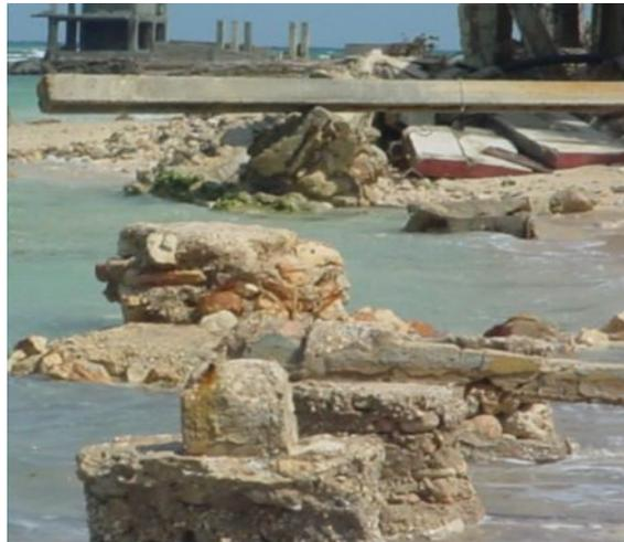
**Fig. 8: Playa La Puntilla afloramiento de cimientos y rocas que estaban cubiertos de arenas**
