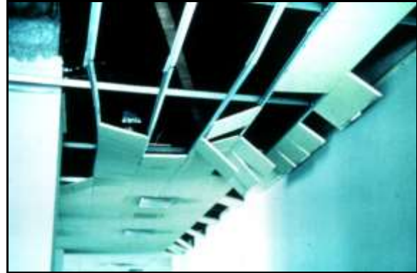
Fig. 4. Caída de cielos rasos.
