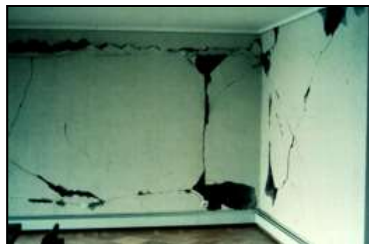
Fig. 9. Rotura de instalaciones debido a falla de muros divisorios.
